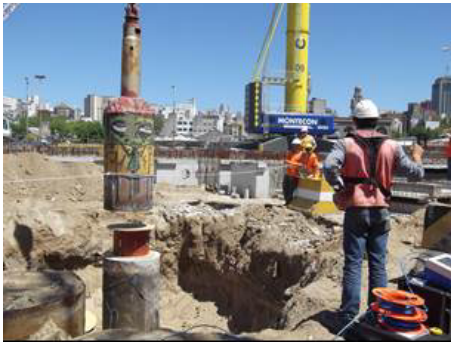
Figura 8. Ensayos preliminares en pilas 1 y 2.
