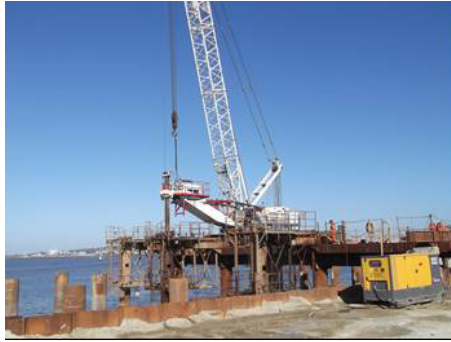
Figura 4. Perforación de pila.
