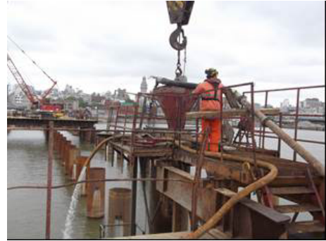
Figura 5. Vaciado de hormigón.
